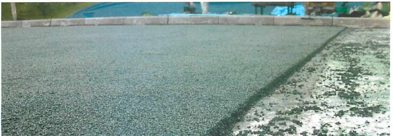
Асфальтобетонное покрытие парка
