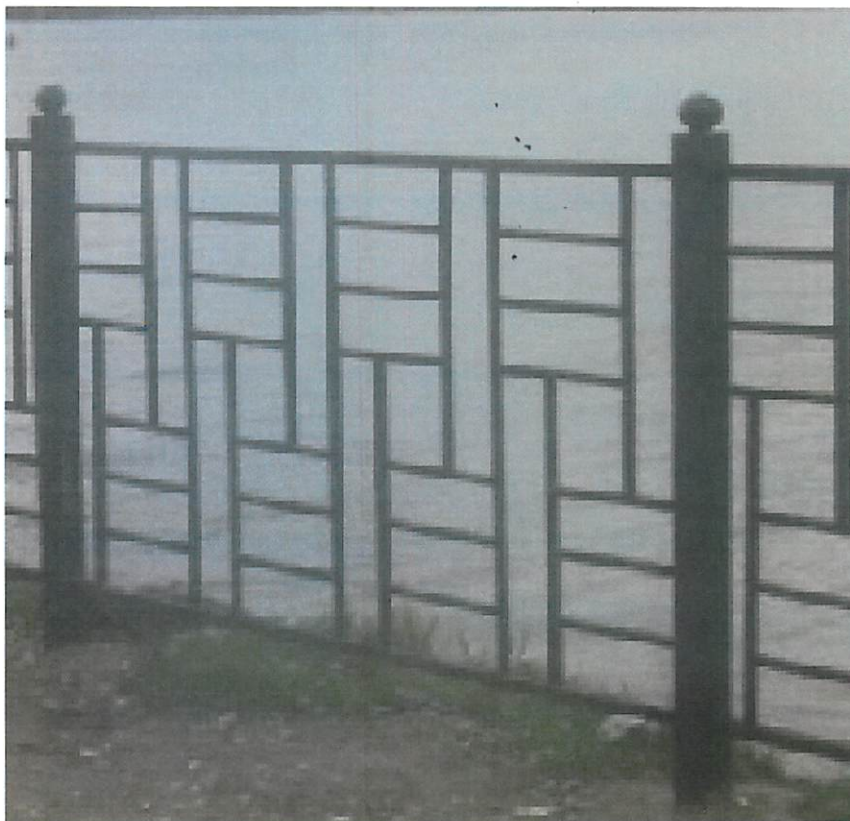
Ограждения набережной р.Кама
